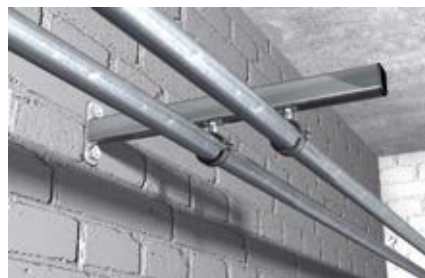
Трубопроводы, закрепленные на консолях
