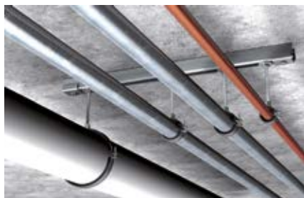
Легкие подвесные трубопроводы
