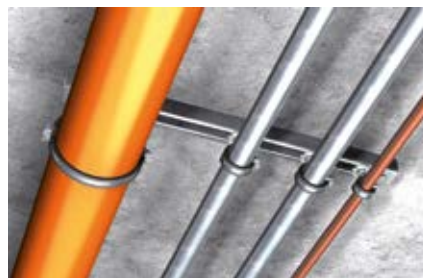
Крепление дренажного трубопровода
